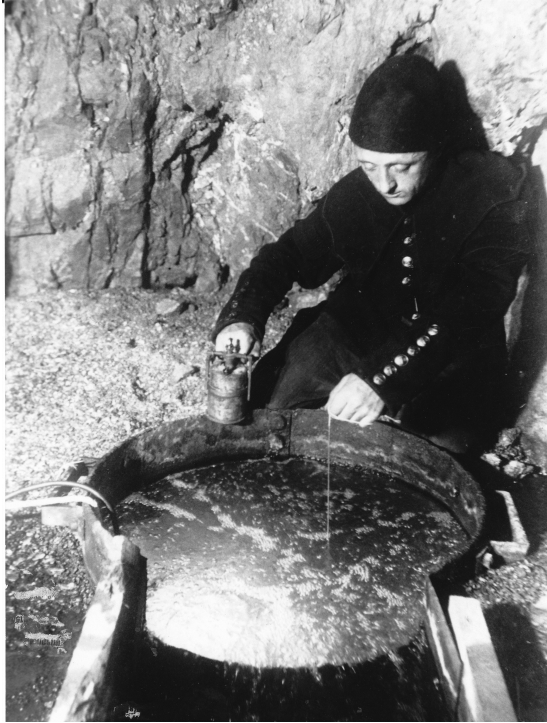
Abb. 6: Thermalwasserzutritte auf der 8. Tiefbausohle auf der Grube Mercur, Abteilung Neuhoﬀnung (Foto Bergbaumuseum Bad Ems).
